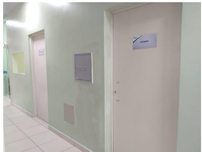
Figura 44: Expurgo / área suja.
