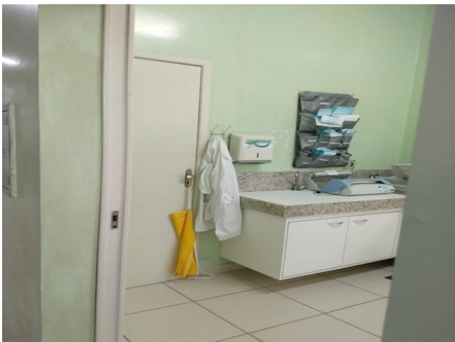
Figura 47: Expurgo / área suja.
