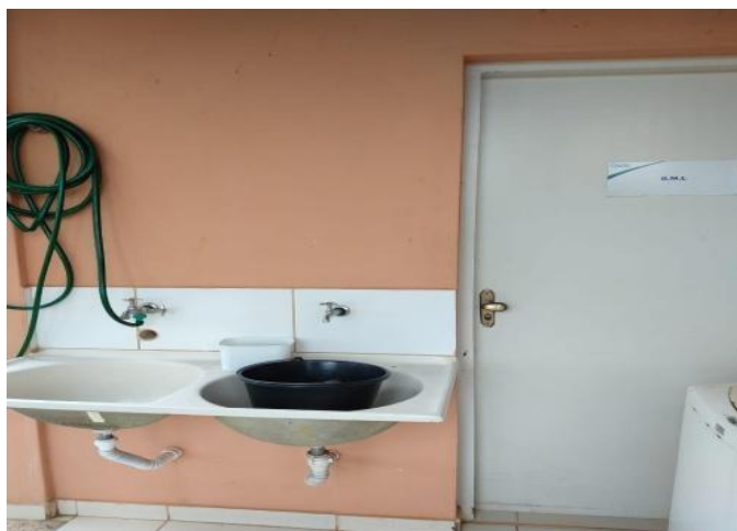
Figura 51: Depósito de material de limpeza (DML) da Clínica Odontológica.
