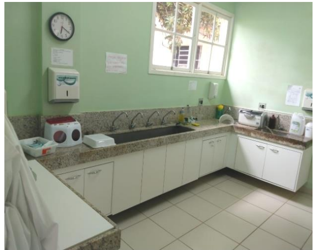
Figura 46: Expurgo / área suja.
