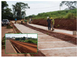
Construção de ciclovias e calçadas que acompanham o novo sistema viário
